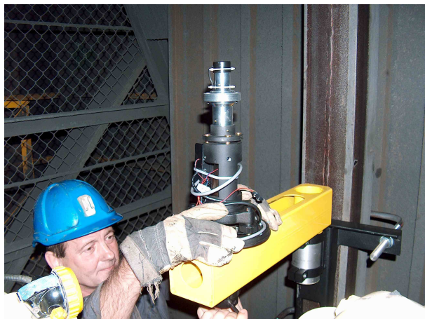
Rys.2. Montaż nadajnika laserowego w szybie
