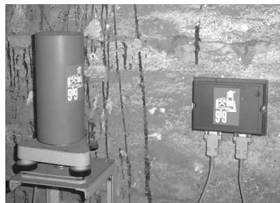
Rys. 2. Czujnik wychyleń zamontowany na wieży budynku kościoła (uwidoczniony na zdjęciu z lewej wraz z układem transmisji i rejestratorem) i na poddaszu szpitala w Rydułtowach
